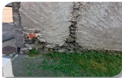
REPRISES de maçonnerie
